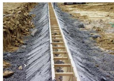
Enrobe en béton C12/15 sur chantier en construction
