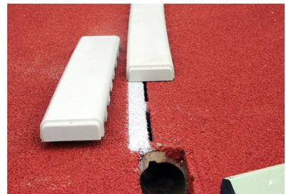
Passage d'un caniveau ouvert à un caniveau à fente
